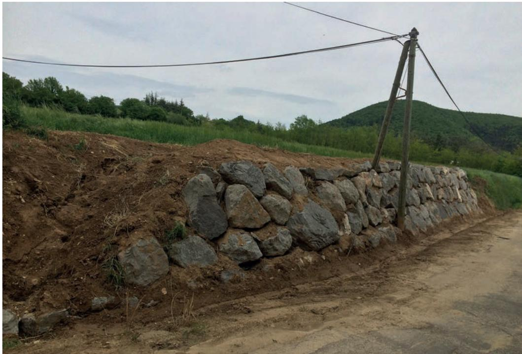
Les travaux de terrassement et d'enrochement sur le chemin du quartier Plaisance sont terminés. Ces travaux permettront que la voie communale ne soit plus envahie par la boue lors de fortes précipitations.
